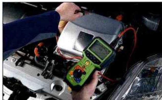
Des équipements spécifiquement développés pour l'activité sont désormais disponibles afin de faire le diagnostic des circuits haute tension.
