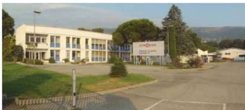
De nouveaux locaux vont accueillir les têtes pensantes de One-Too à proximité de Nice (06).
